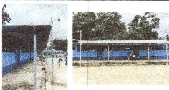
Foto 3 módulo de salón de actividades: Cambio de techo
