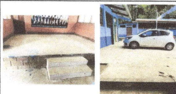
Foto 4 módulo de salón de actividades: Piso de concreto y losa de patio
